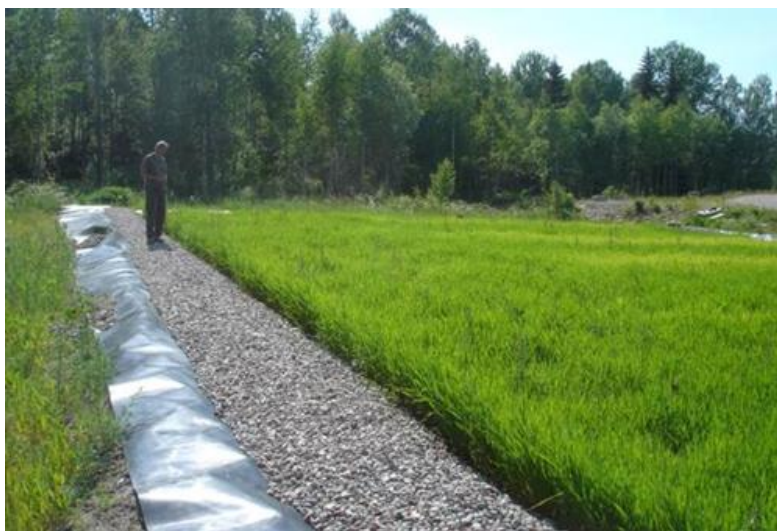
Figur 4. Beskickning via spridarvall av makadam. Foto från Kvittens avfallsanläggning i Strängnäs för behandling av lakvatten från deponi (WRS).
