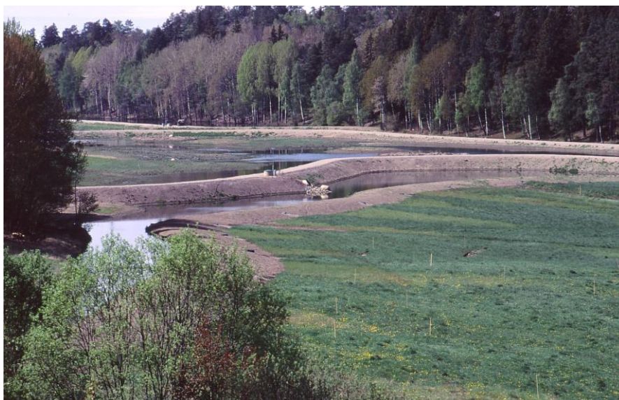
Figur 5. Exempel på översilning av utgående vatten från avloppsreningsverk. Översilning med självfall via fördelningsdike och horisontellt lagda rör i en spridningsvall i Alhagens våtmark, Nynäshamns kommun.
