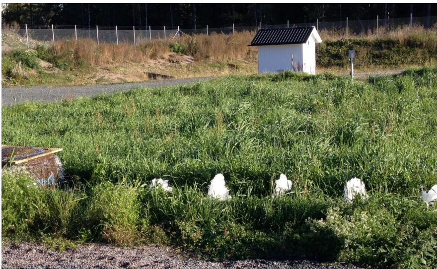
Figur 6. Exempel på översilning av utgående vatten från avloppsreningsverk. Pulsjärr med trycksatt fördelning vid Forsmarks reningsverk, Östhammars kommun.
