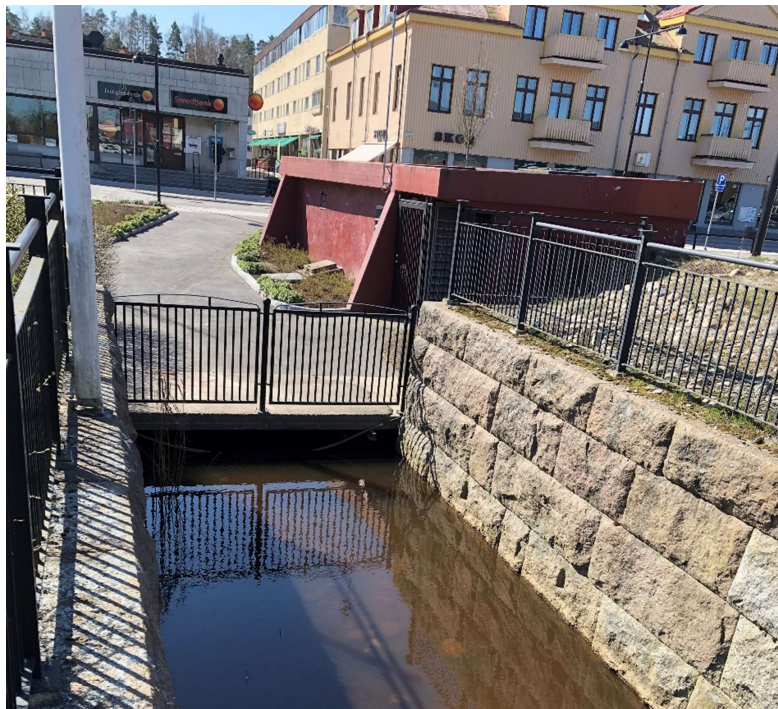
Figur 7. Överbyggnad till spillvattenpumpstation i rödmålad betong.
