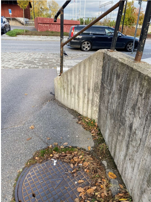
Figur 6. Stödmur vid trappa utanför Swedbank placerad över dagvattenledning.
