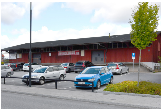
Ovan: Godsmagasinet från 1950 närmast stationen med bevarad lastkaj.
