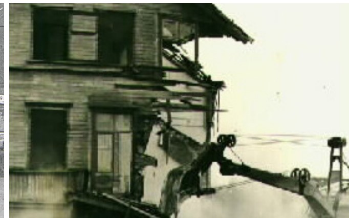
Rivning av kvarteret Marieström. 1968. Källa: Sörmlands museum
