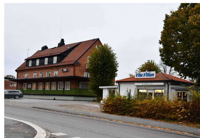
Ovan: Bryggeribygnaden som tidigare innehöll brygghus och maltvindar, jästkällare och ångpannehus.
