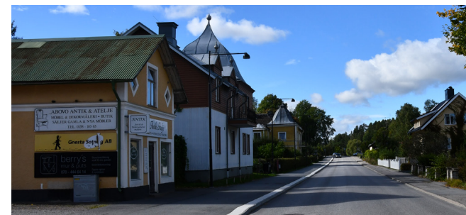
Ovan: Den f.d. mejeriboden där mjölken från mejeriet såldes. Byggnaden har byggts om och fått nya tillbyggnader men bidrar ändå till förståelsen för riksintresset.
