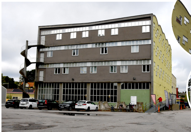
Tvålfabriken med dess karaktäristiska modernistiska och lekfulla former med bland annat friliggande betongelement och färgsstarka fasadkulörer.
