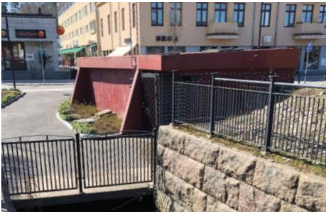
Befintlig pumpstation inom planområdet.
