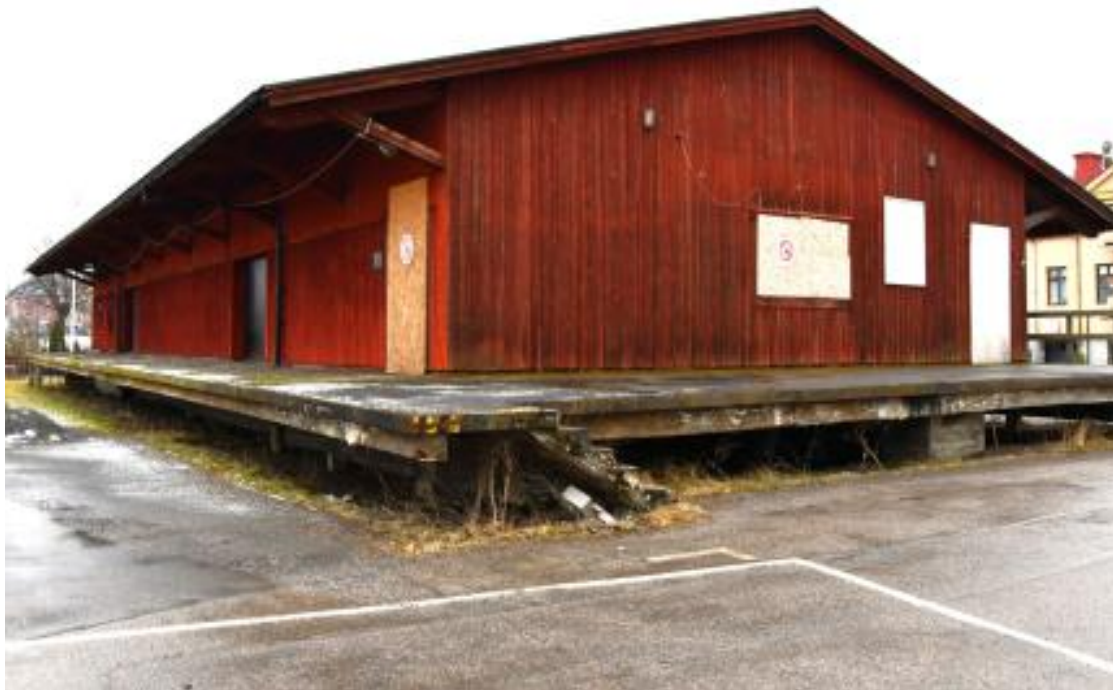
Den tidigare godsmagasinbyggnaden inom planområdet.
