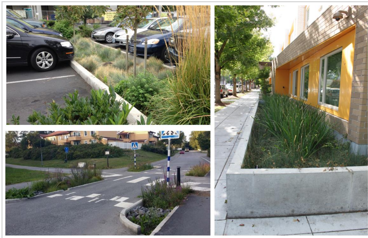
Figur 4-1. Exempel på växtbäddar i stads- och gatumiljö. Övre till vänster: dagvatten från parkeringsyta leds in i nedsänk växtbädd via öppningar i kantstenen. Foto WRS i Stockholm Vatten och Avfall (2023a). Nedre till vänster: outnyttjade ytor som refuger kan användas till dagvattenhantering (Banach m.fl., 2015). Höger: upphöjd växtbädd som tar hand om takdagvatten via husets stuprör. Foto WRS i Stockholm Vatten och Avfall (2023a).
